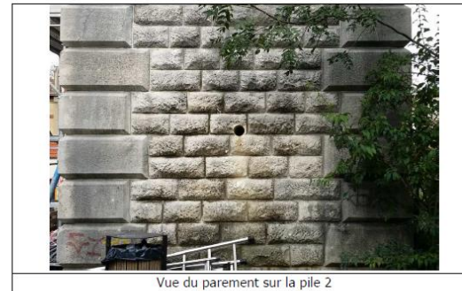
Vue du parement sur la pile 2
